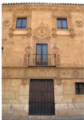
Fachada de la Casa de las Muertes
